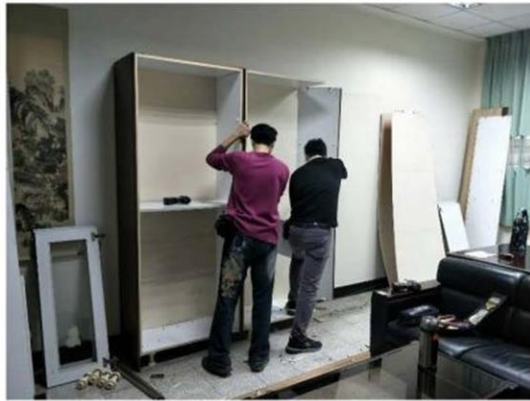
108.01.19 拆除「教師交誼廳」櫃子
