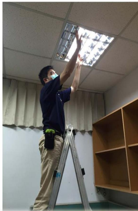
108.01.29加裝天花板燈管
